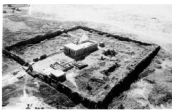
Fig. 2.17. Fotografia del Tempio di Dendera e del territorio limitrofo visti dall'alto. È probabile che il tempio e le costruzioni che lo circondano fossero stati eretti come monastero cristiano. Si vede l'alto muro che circonda il grande territorio attorno al tempio (tratto da [1062], p. 64).
