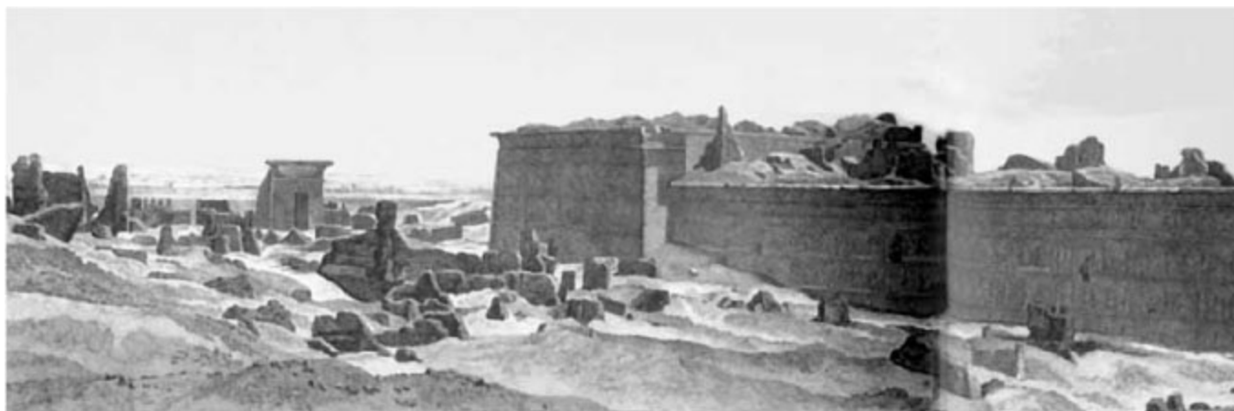
Fig. 2.13. Il grande Tempio di Dendera visto da dietro: un panorama di distruzione totale. È probabile che si trattasse degli effetti dei colpi dell’artiglieria o di esplosivi piazzati sotto le fondamenta delle costruzioni (tratto da [1100], A, vol. IV, PL. 3).
